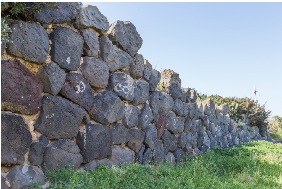
Fig. 7 - Le mur de contrescarpe (photo Unicity S.p.A.)
