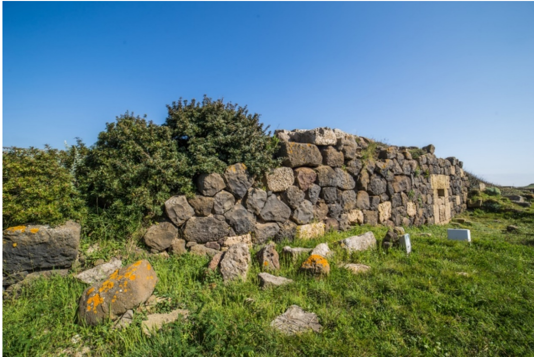
Fig. 4 - le mur d'enceinte en basalte avec blocs réguliers en grès (photo Unicity S.p.A.)
