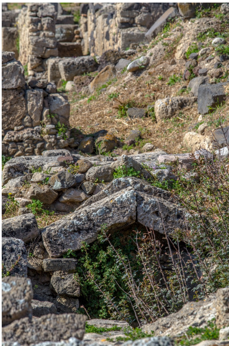
Fig. 8 - Citerne couvertes de blocs à double pente (photo Unicity S.p.A.)
