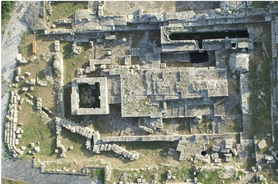
Fig. 21 - Le temple des demi-colonnes vu du haut (photo Unicity S.p.A.) Réélaboration C. Tronchetti)
