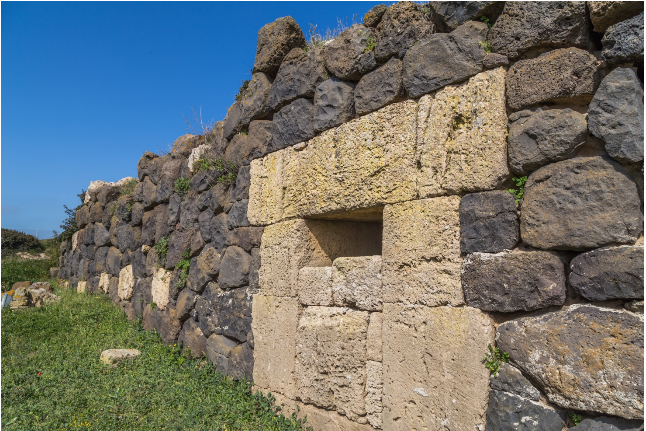
Fig. 10 - Le mur punique avec poterne condamnée à l'époque romaine (photo Unicity S.p.A.)
