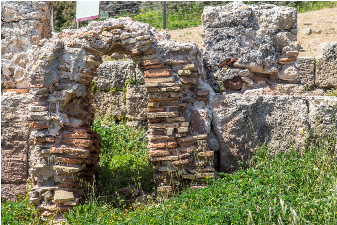
Fig. 30 - Thermes n°1 : bouche d'un prae-furnium (photos Unicity S.p.A.)
