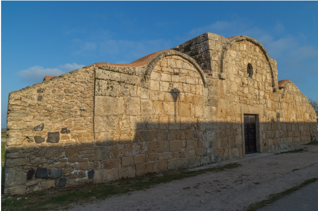
Fig. 51 - Façade de l'église San Giovanni (photo Unicity S.p.A.)
