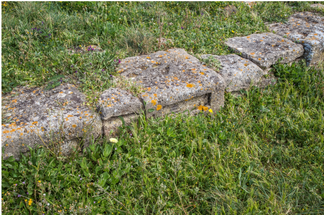
Fig. 15 - Soubassement d'édifice romain construit avec les stèles du tophet punique (photo Unicity S.p.A.)
