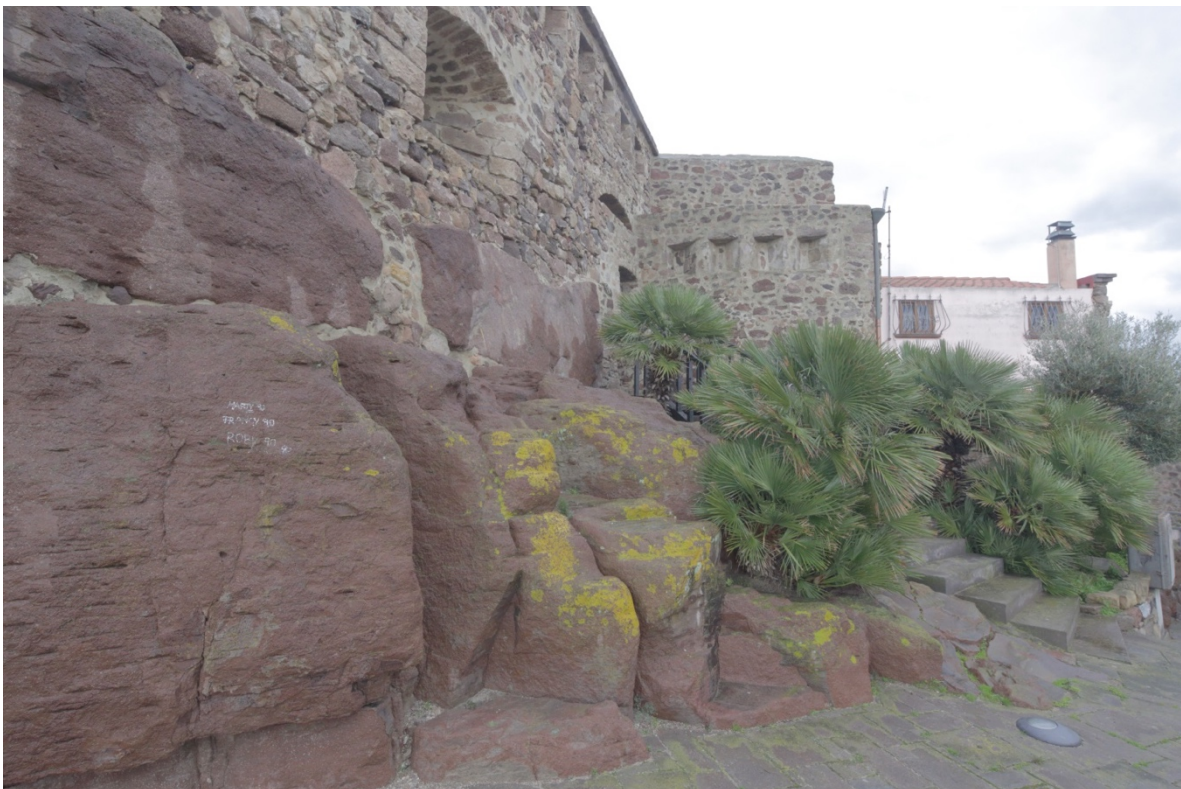
Fig. 1 - Fort su Pisu. Détail des blocs en trachyte représentant des vestiges du nuraghe (photo Unicity S.p.A.).
