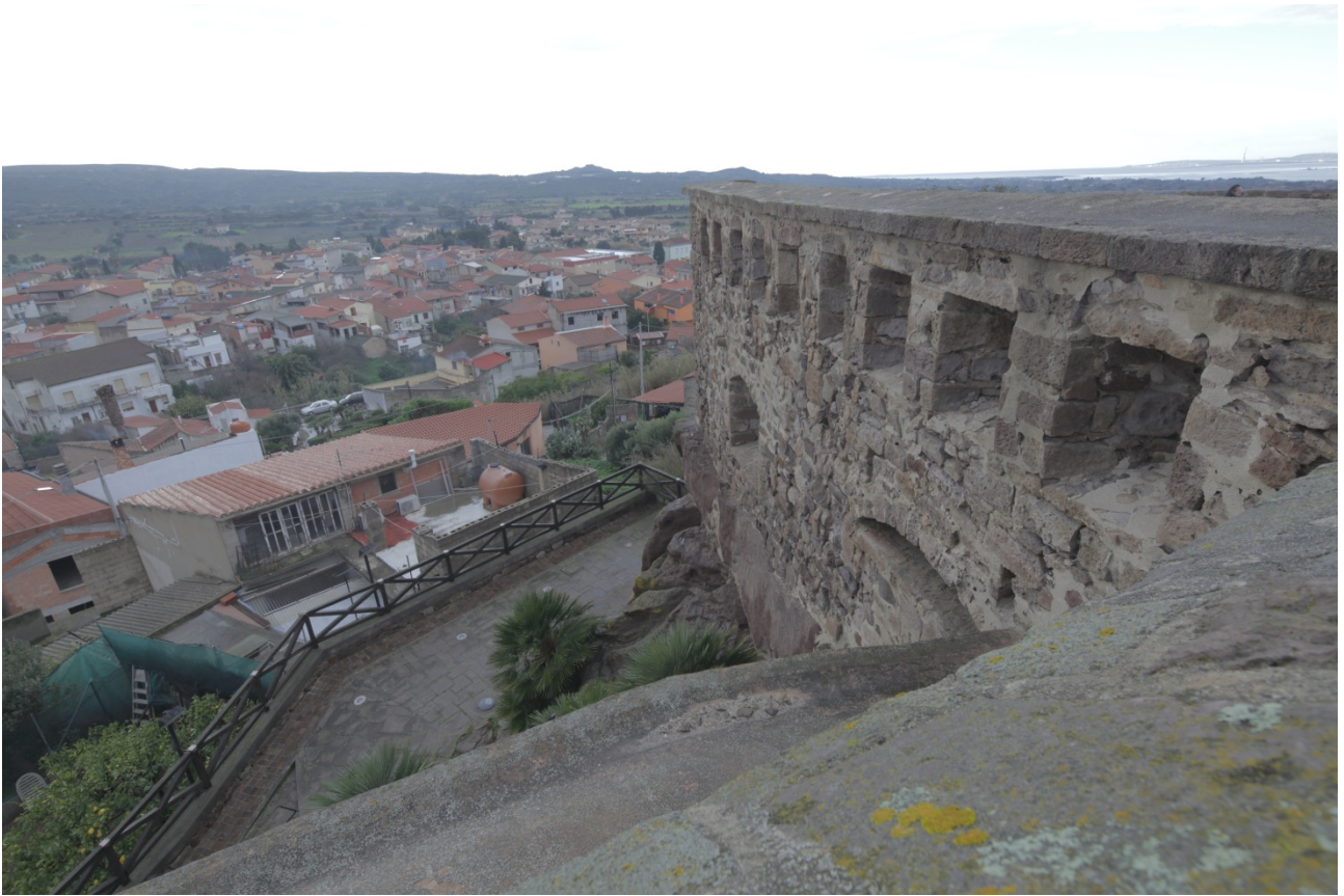
Fig. 6 - Une série de meurtrissures pour les canons situées le long du périmètre du Fort (photo Unicity S.p.A.).
