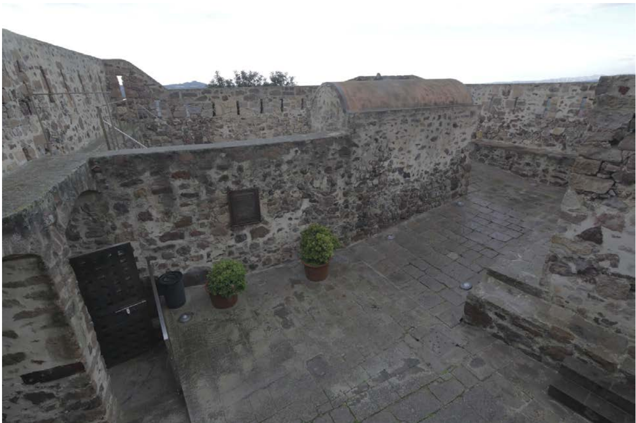
Fig. 3 - Vue d'ensemble de la cour du fort de la Maison de Savoie et de la poudrière avec voûte en berceau (photo Unicity S.p.A.).
