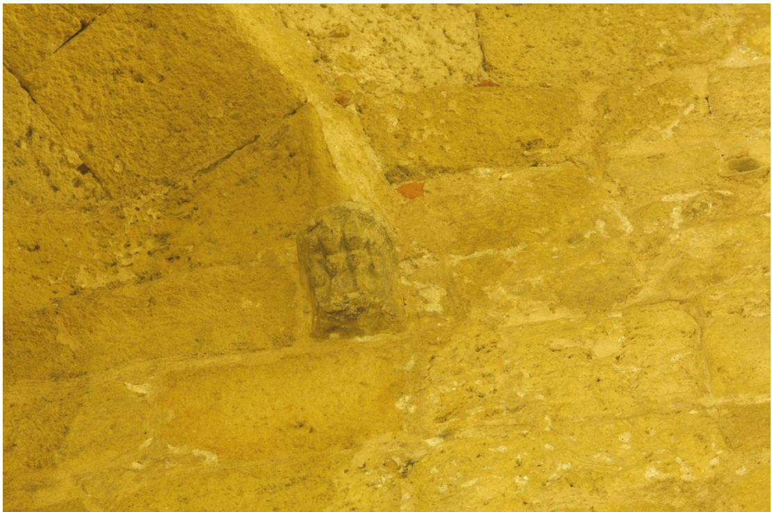
Fig. 7 - Sant'Antioco, sommier de la coupole en forme de patte de lion (Photo Unicity S.p.A.).
