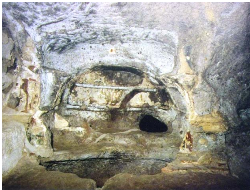
Fig. 1 - Arcosolium B/II, dans lequel on aperçoit les dommages provoqués par la réutilisation à une époque successive (Porru 1989 tab. XIVa).
