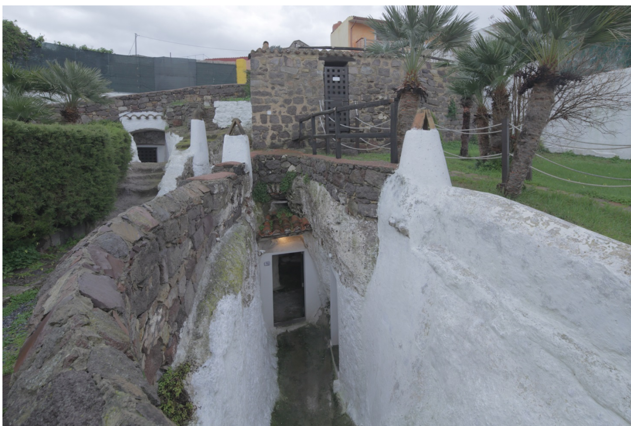
Fig. 1 - Vue d'ensemble d'une partie du village souterrain tel qu'il se présente aujourd'hui ; on aperçoit au fond le fort de la Maison de Savoie (photo Unicity S.p.A.).
