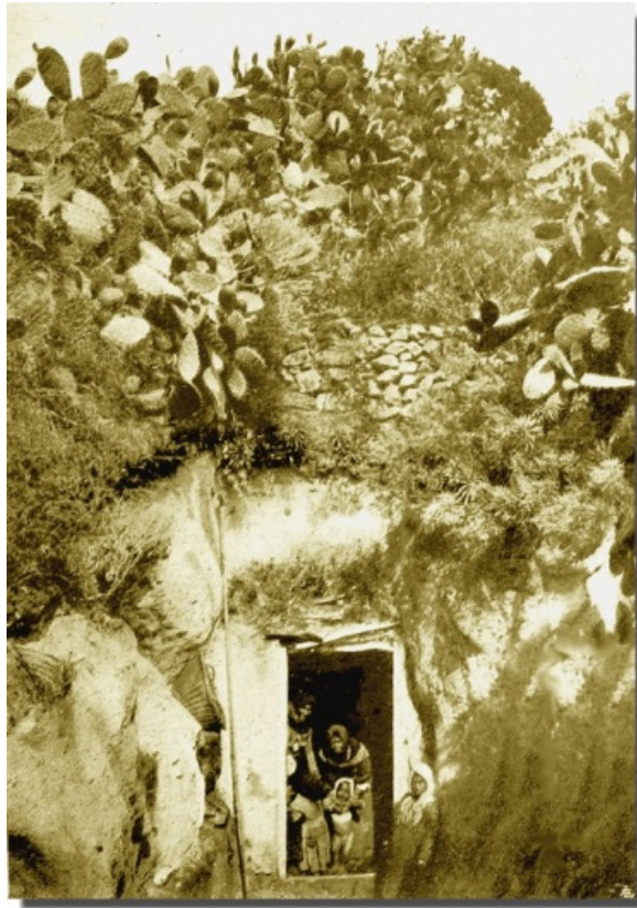
Fig. 13 - Photo d'époque du village souterrain encore habité ( http://www.parcogeominerario.eu/images/Grutti.jpg )
