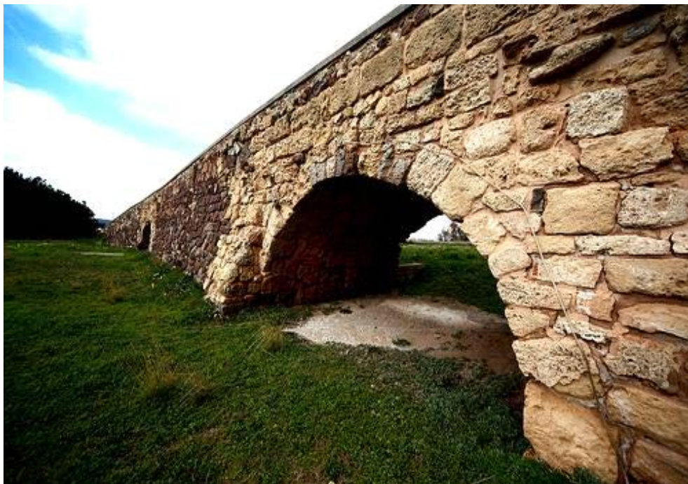
Fig. 3 - Sant'Antioco, pont construit sur les vestiges du pont romain ( https://www.flickr.com/photos/vincenzovacca/8367735306/in/set-72157632483827575 )
