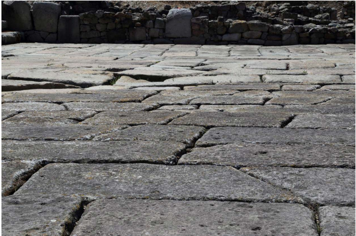
Fig. 2 - Le dallage de la place (photo Unicity S.p.A.).
