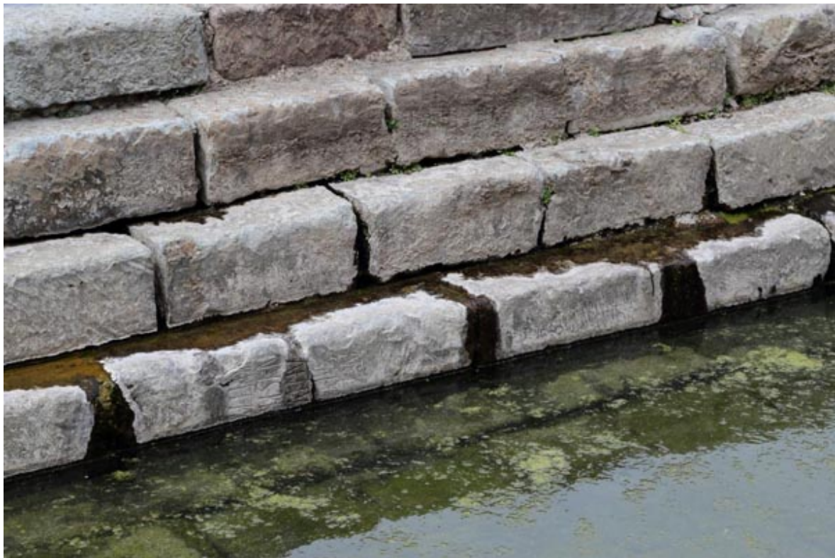
Fig. 1 - Fragments d'inscription réutilisés pour remplacer les marches endommagées de la natatio (photo Unicity S.p.A.)
