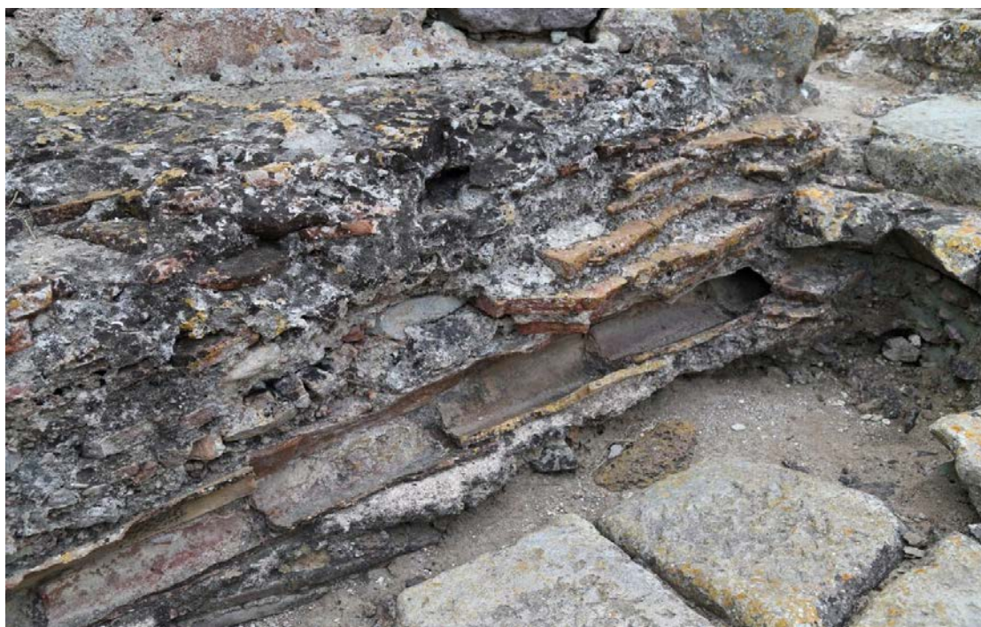
Fig. 3 - Canalisazione qui se trovait à l'origine à l'intérieur d'un ouvrage en maçonnerie (photo Unicity S.p.A.).
