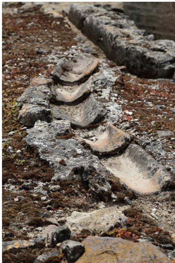
Fig. 1 - Détail d'une rigole réalisée avec des tuiles (photo Unicity S.p.A.).
