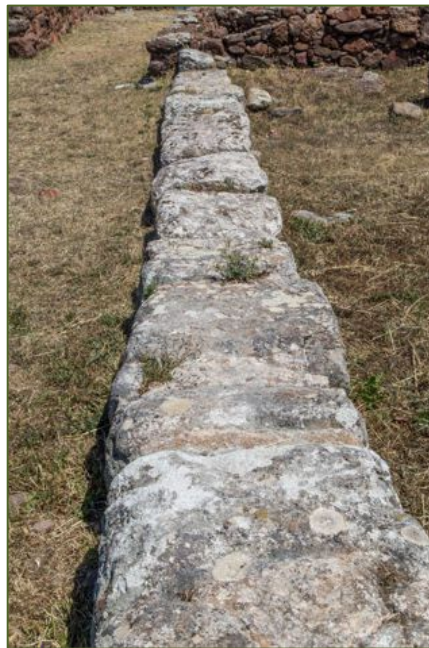
Fig. 7 - Mur porteur en opus quadratum (photo Unicity S.p.A.).
