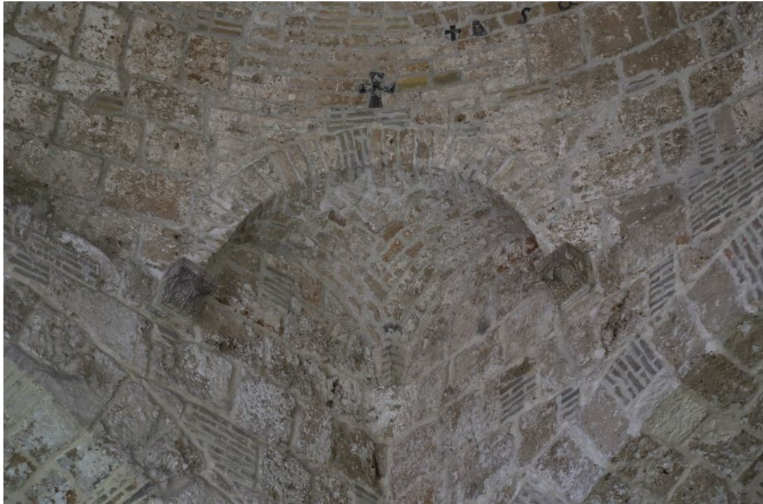
Fig. 2 - Detalle de la semiarista de unión entre la cúpula circular y el tambor cuadrado (foto de Unicity S.p.A.).
