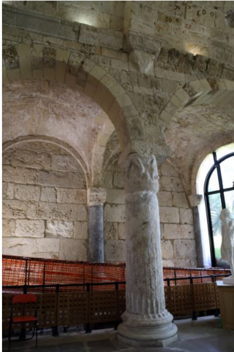
Fig. 3 - Elementos arquitectónicos de spolia (base, columna, capitel) de la nave derecha del brazo oriental (foto de Unicity S.p.A.).
