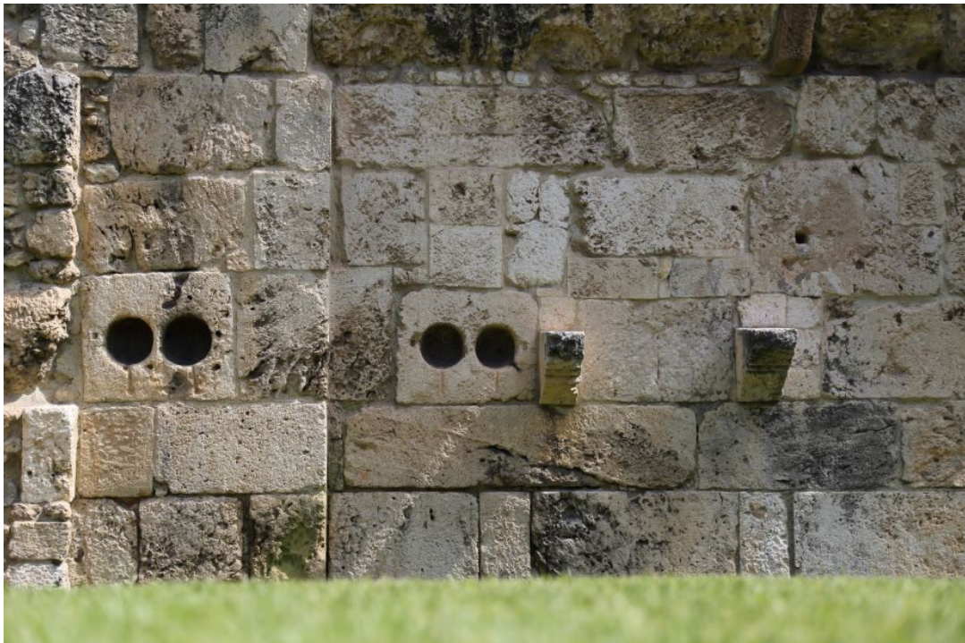
Fig. 3 - Bloques de piedra con espacios para las urnas que han usado en el exterior del muro sur del brazo oriental (foto de Unicity S.p.A.).
