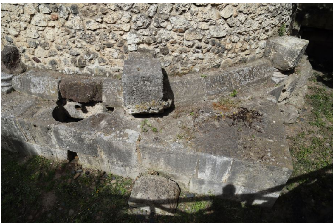
Fig. 2 - Detalle de la base del ábside (foto de Unicity S.p.A.).
