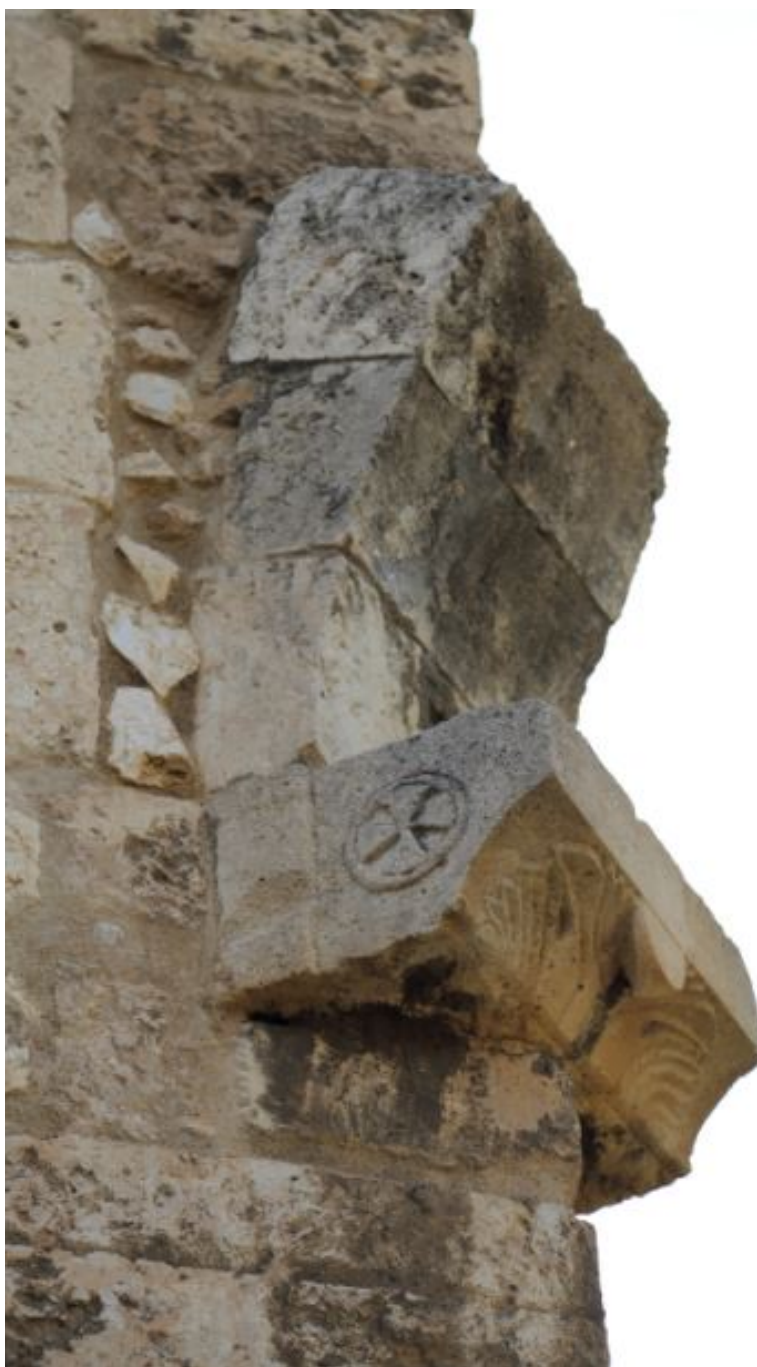
Fig. 1 - Ménsula rota en el exterior del cuerpo cupulado (foto de Unicity S.p.A.).
