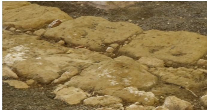
Fig. 3 - Basilichetta: detalle de la técnica de construcción (foto de Unicity S.p.A.).
