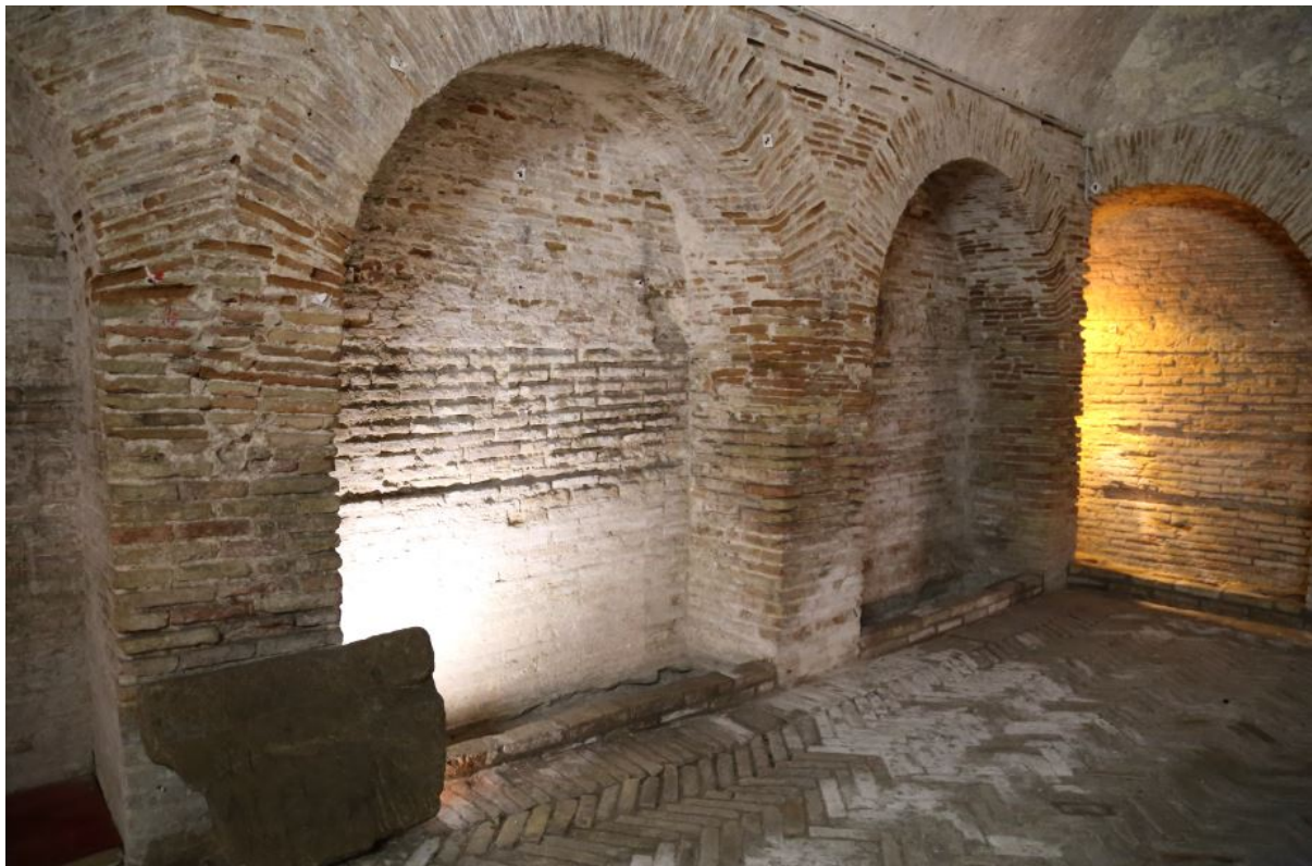
Fig. 2 - Segunda iglesia subterránea: interior (foto de Unicity S.p.A.).
