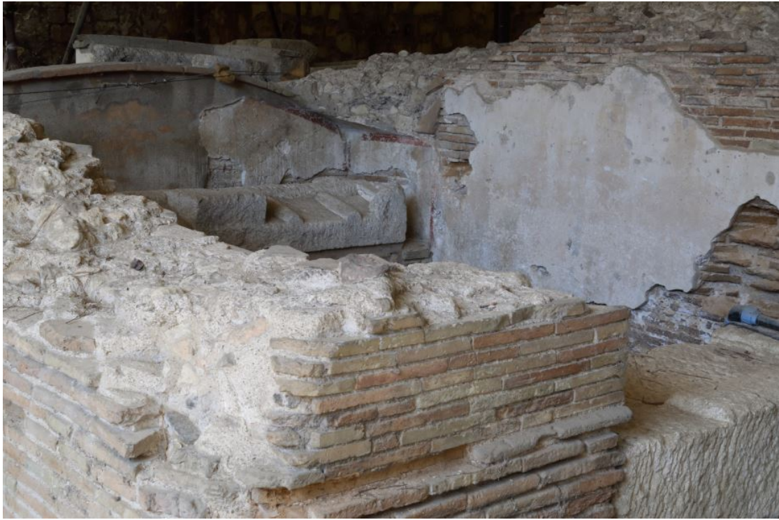
Fig. 2 - Mausoleo: detalle de la técnica de construcción con material de terracota (foto de Unicity S.p.A.).
