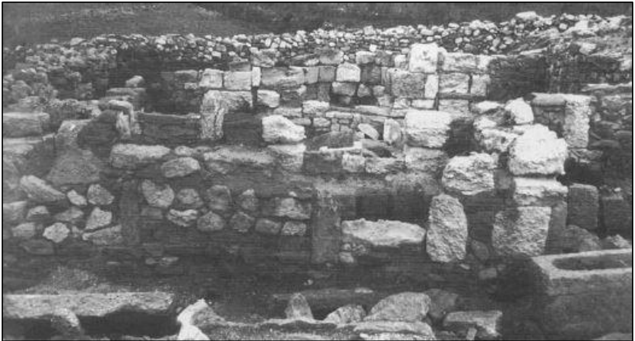
Fig. 4 - Muro de opus africanum en el pasillo de unión entre el espacio A y la basílica funeraria (de FANTAUZZI, DE VINCENZO 2013, pág. 9, fig. 2).
