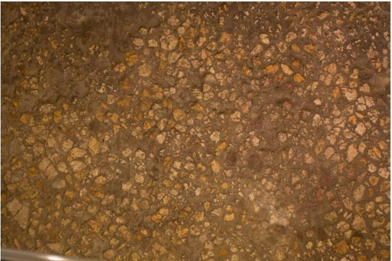
Fig. 1 - Suelo sin asfaltar del porticus (foto de Unicity S.p.A.).
