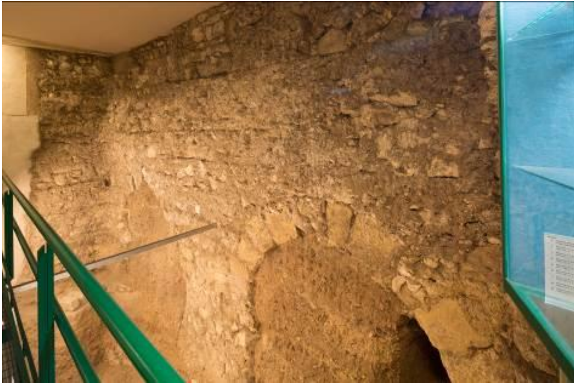
Fig. 2 - Muro oblicuo y tabique tangente con arcadas inferiores visibles en el yacimiento arqueológico (foto de Unicity S.p.A.).
