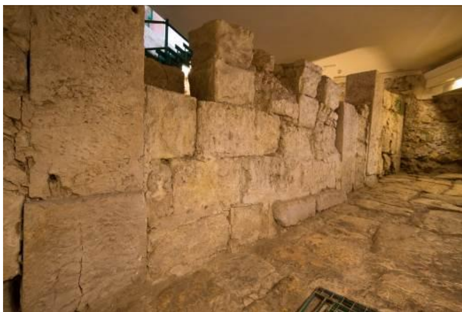
Fig. 1 - Muro en opus africanum (foto de Unicity S.p.A.).
