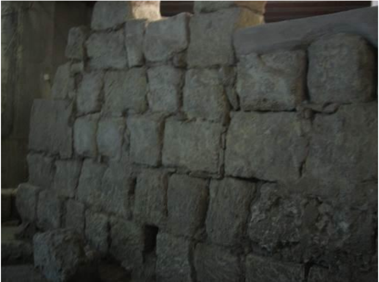
Fig. 3 - Pared en opus quadratum irregular (foto de R. Martorelli).
