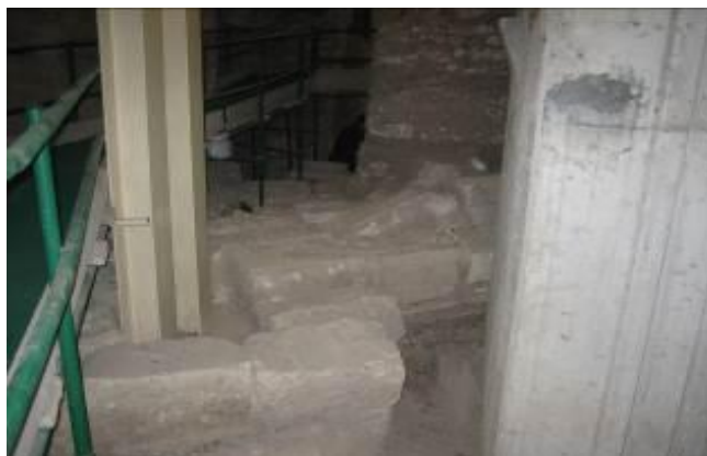
Fig. 3 - Primer derrumbe (foto de R. Martorelli).
