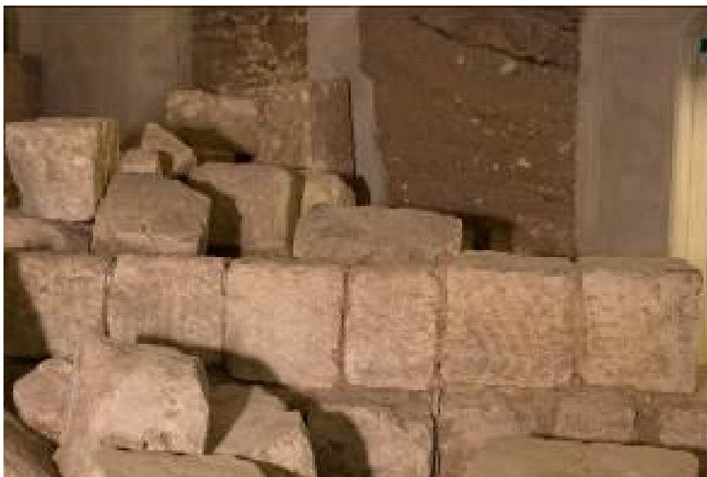
Fig. 1 - Muro transverso formado por bloques reutilizados recuperados del primer derrumbe y construido sobre una capa de hundimiento del pórtico (foto de R. Martorelli).
