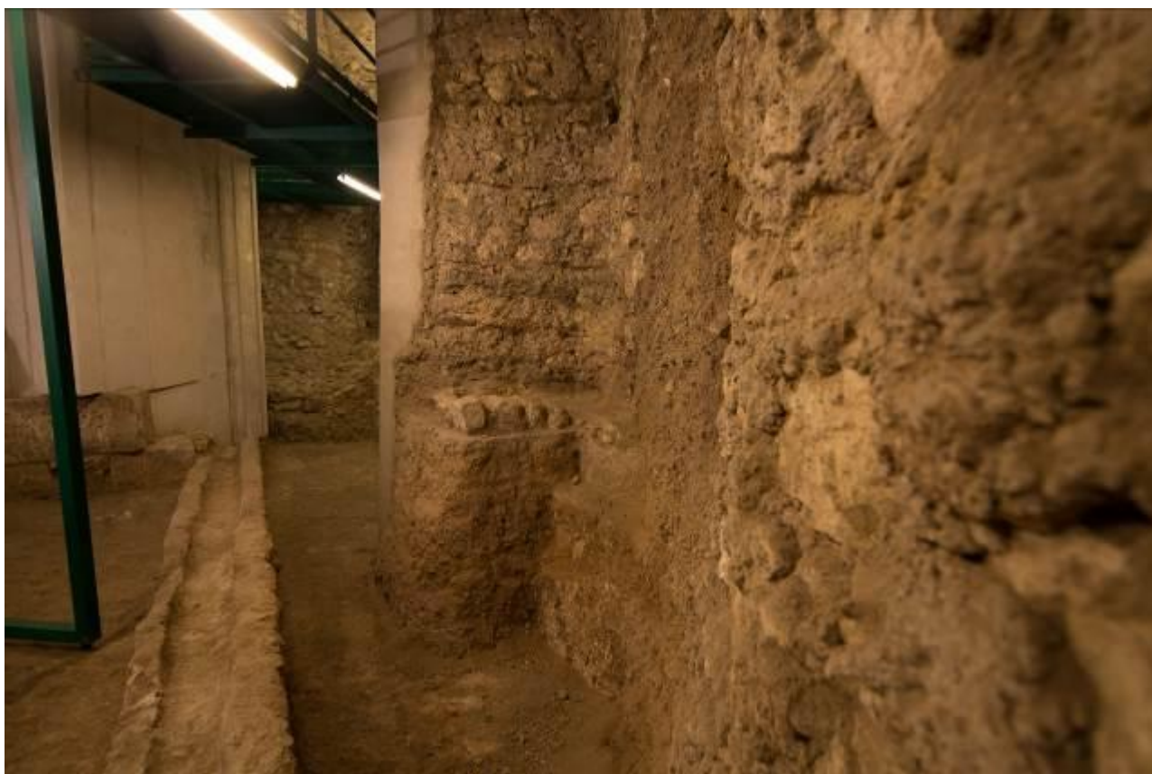
Fig. 3 - Canaleta adyacente a la infraestructura de la iglesia (foto de Unicity S.p.A.)
