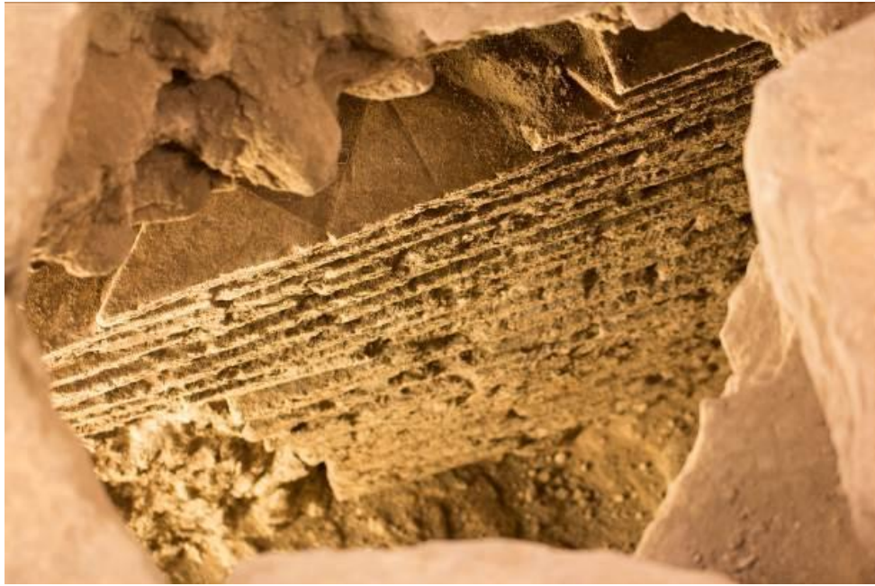
Fig. 2 - Revestimiento del interior del conducto del alcantarillado (foto de Unicity S.p.A.).
