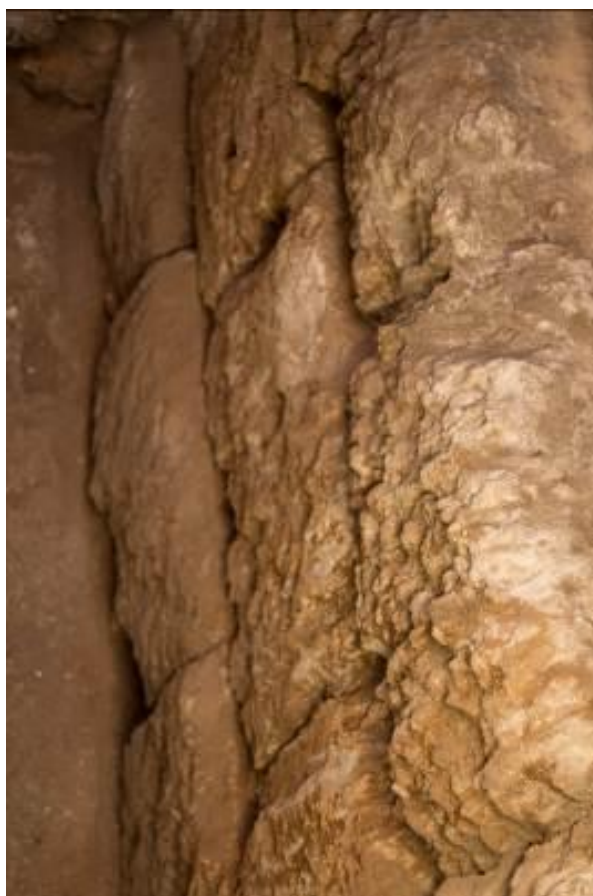
Fig. 2 - Bloques almohadillados del revestimiento del podio del santuario (foto de Unicity S.p.A.)
