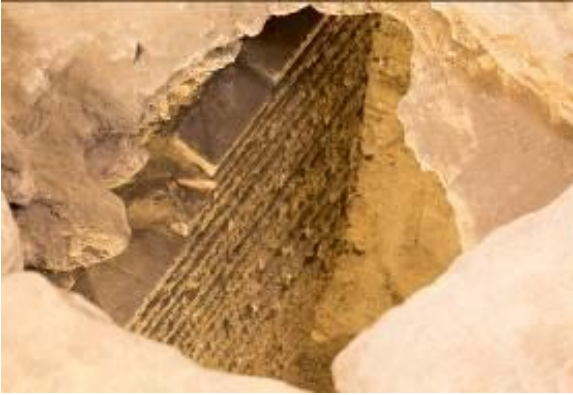
Fig. 2 - Pared interna de las tuberías del alcantarillado (foto de Unicity S.p.A.)
