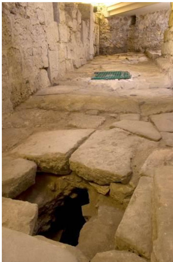
Fig. 1 - Pozo de registro del alcantarillado abierto sobre una calle empedrada (foto de Unicity S.p.A.).
