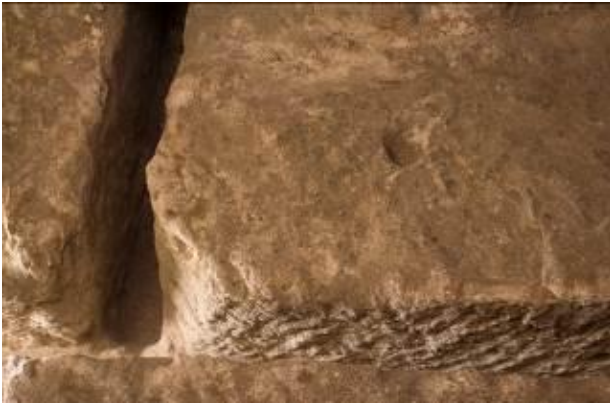
Fig. 3 - Particular del corte entre dos bloques calcáreos (foto de Unicity S.p.A.).
