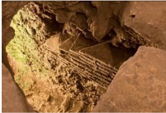
Fig. 3 - Tramo del alcantarillado en parte excavado en la roca y en parte construido con material de terracota (foto de Unicity S.p.A.).
