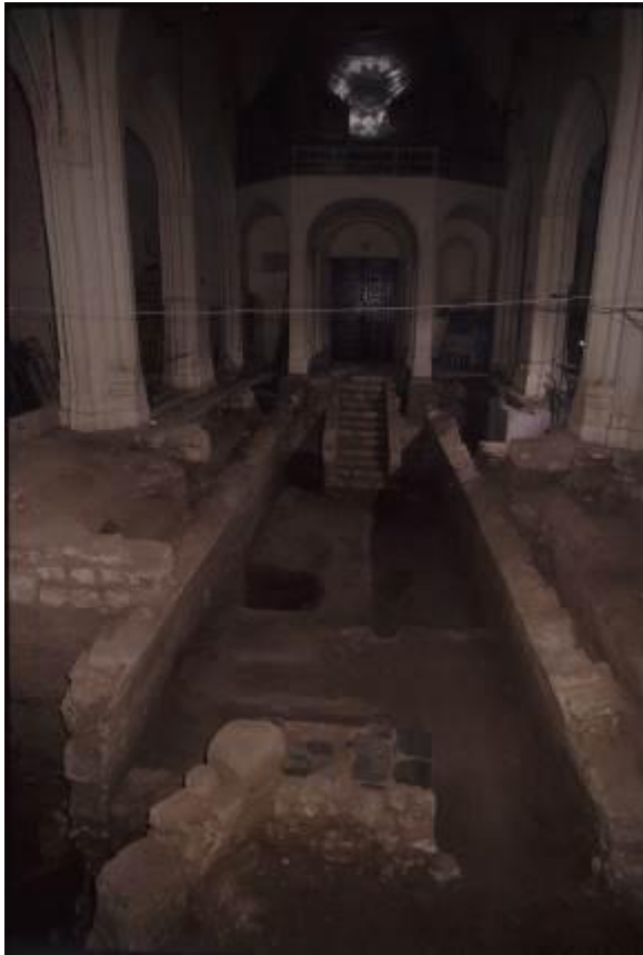
Fig. 9 - Nave central sin suelo y excavación de la cripta mayor con altar y escalinata (foto de AFS).
