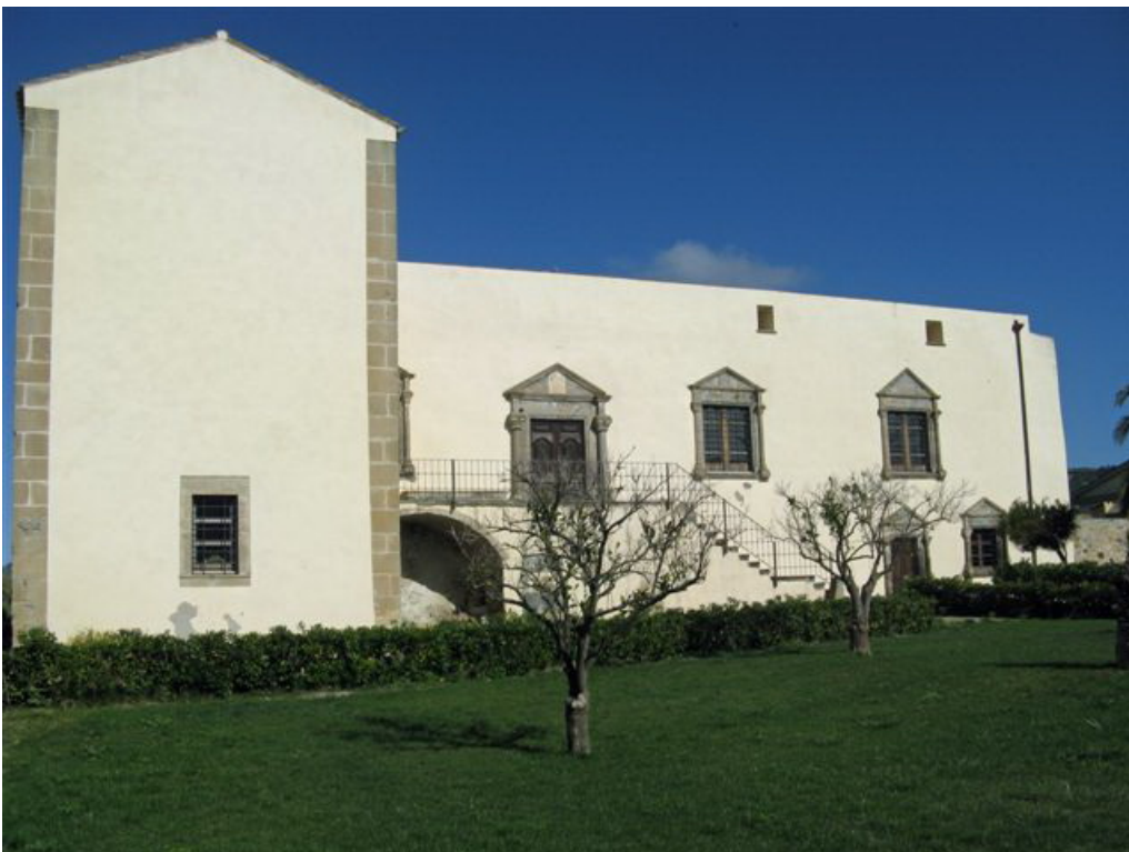
Fig. 1 - El «Polo museale Casa Zapata» (de http://www.unionecomunimarmilla.it/VisitaTerritorio/fotoVisitaITerritorio/Barumini_Casa_Zapata.jpg ).
