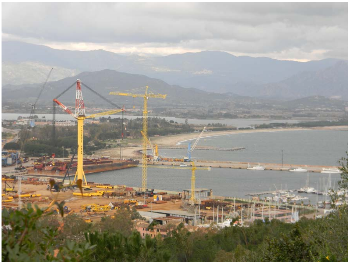
Fig. 3 - Obras de Intermare Sarda (foto de C. Nieddu).
