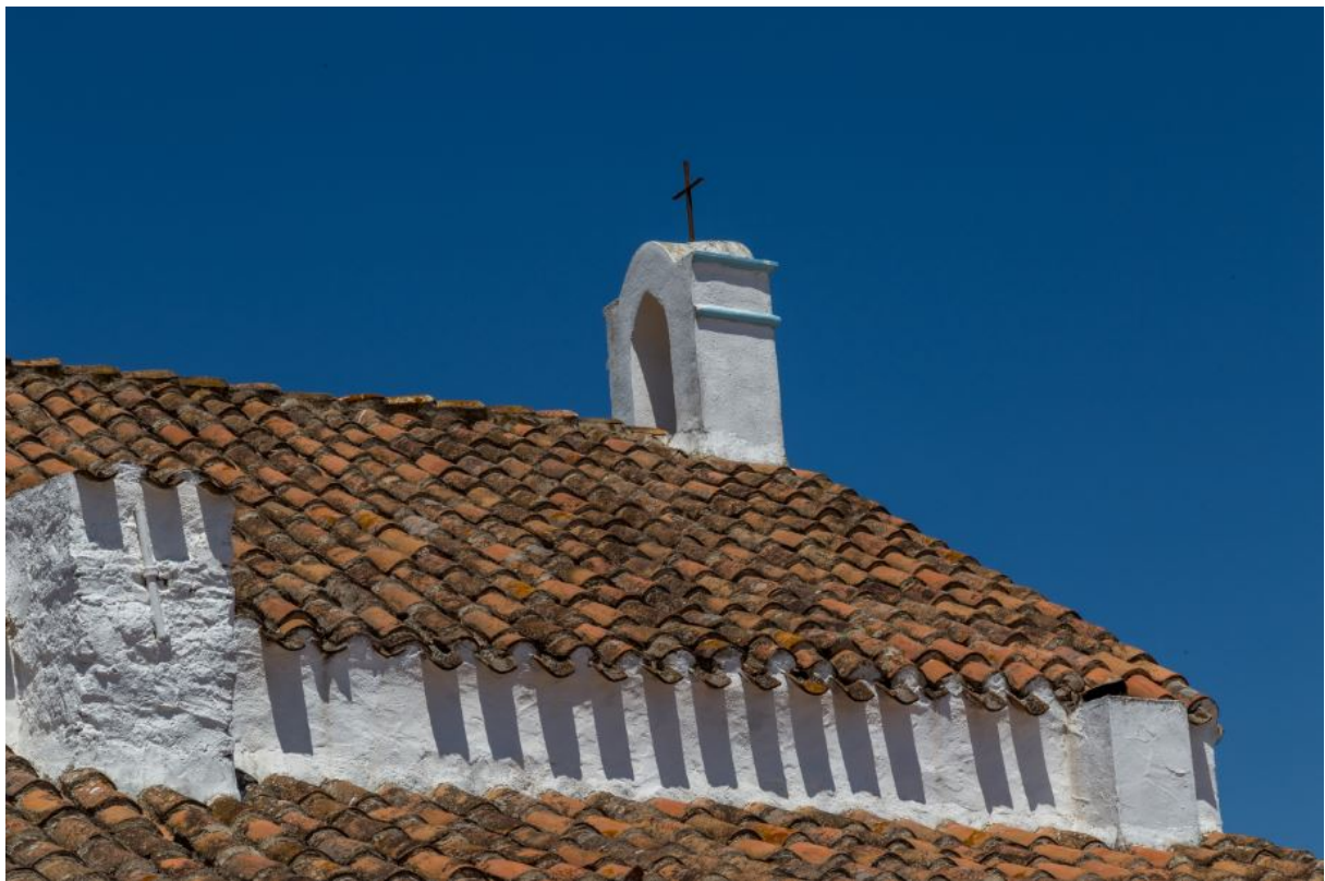
Fig. 3 - Detalle del techo y de la espadana (foto de Unicity S.p.A.).
