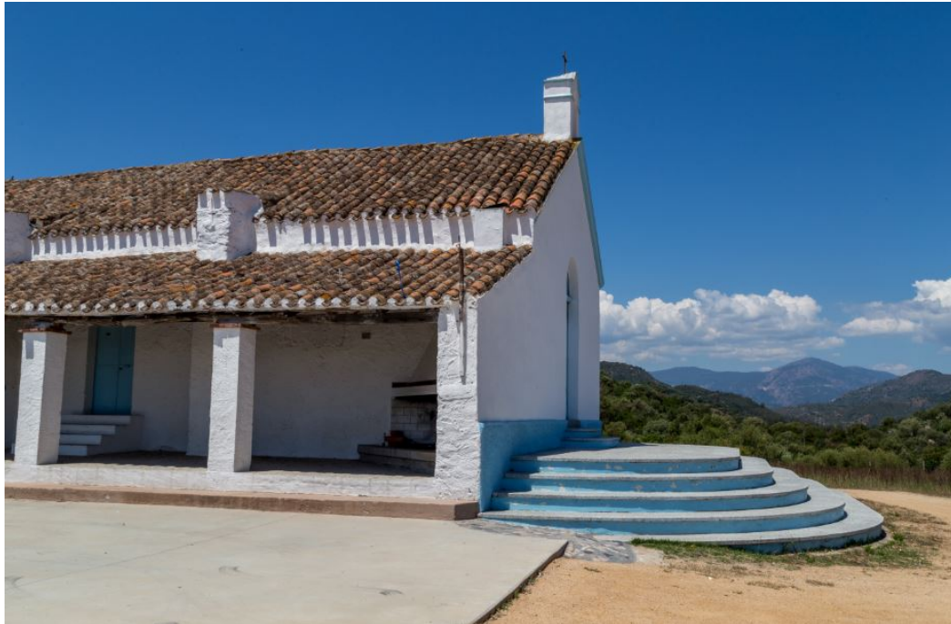
Fig. 4 - El porticado con el acceso secundario y la pequeña chimenea (foto de Unicity S.p.A.).
