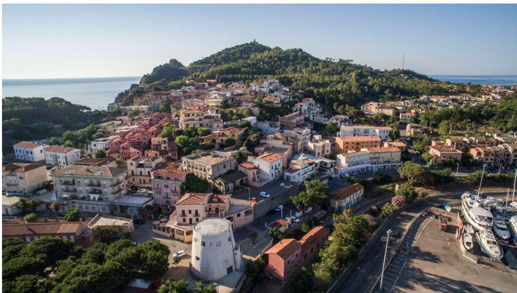
Fig. 7 - La torre de S. Miguel y, al fondo, el faro de Bellavista (foto de Unicity S.p.A.).
