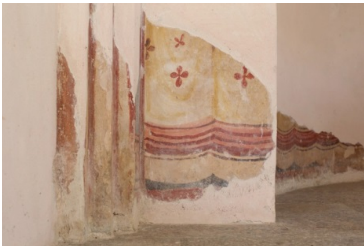
Fig. 1 - El telón decorativo en la parte inferior del ábside (foto de Unicity S.p.A.).
