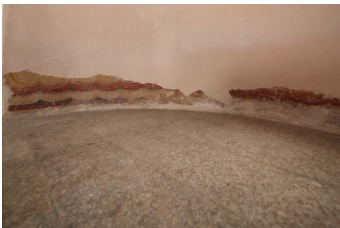
Fig. 3 - El telón decorativo en la parte inferior del ábside (foto de Unicity S.p.A.).
