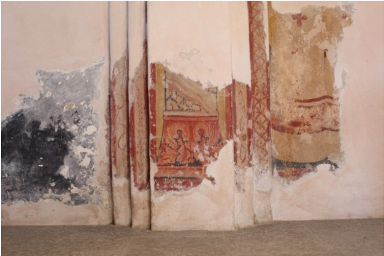
Fig. 4 - El telón decorativo en la parte inferior sur (foto de Unicity S.p.A.).
