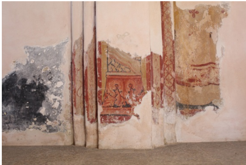
Fig. 3 - Detalles de la decoración pictórica de las paredes laterales (foto de Unicity S.p.A.).
