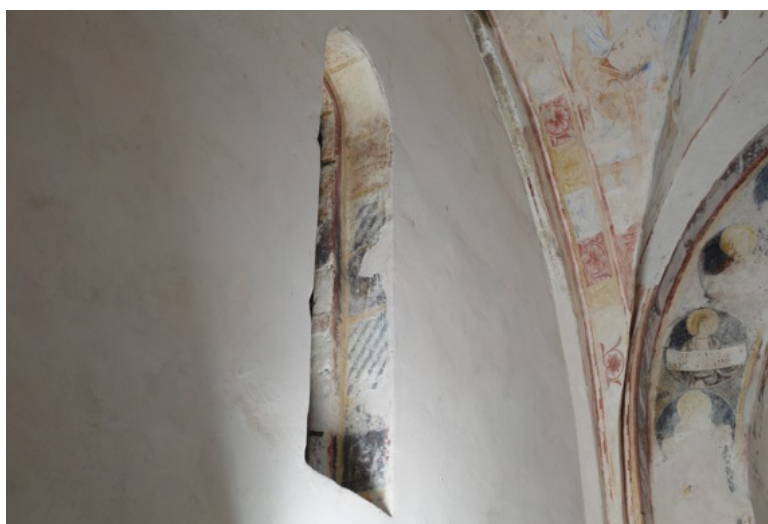
Fig. 1 - Detalles de la decoración pictórica de las paredes laterales (foto de Unicity S.p.A.).
