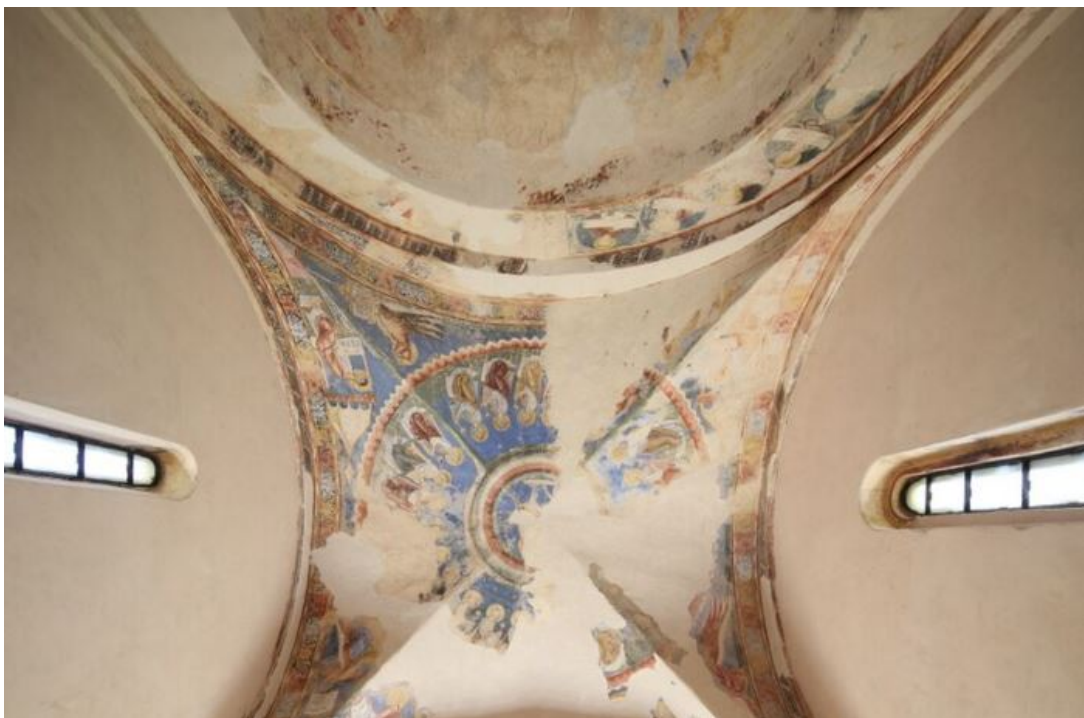
Fig. 3 - La bóveda de arista de una de las crujías (foto de Unicity S.p.A.).
