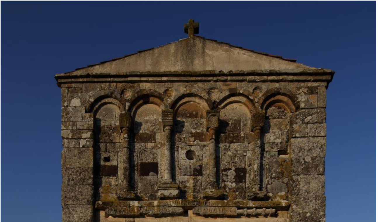
Fig. 5 - Detalle de la fachada con los cuencos de cerámica (foto de Unicity S.p.A.).
