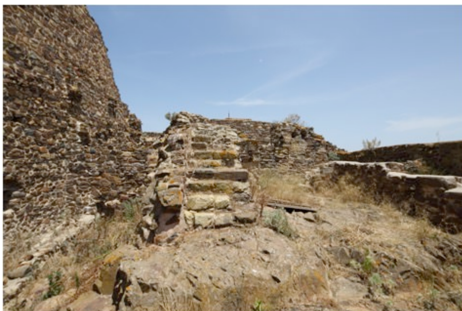
Fig. 10 - Los escalones que comunicaban los patios (foto de Unicity S.p.A.).
