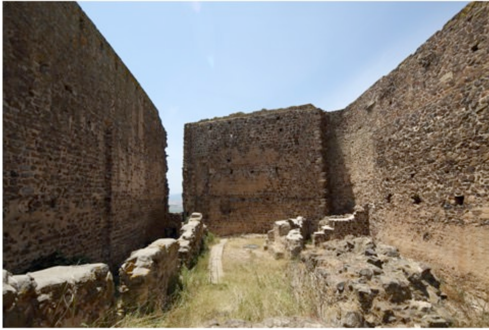
Fig. 13 - El interior del castillo visto desde el este. En los muros todavía se notan los orificios donde se colocaban las vigas de madera (foto de Unicity S.p.A.)
