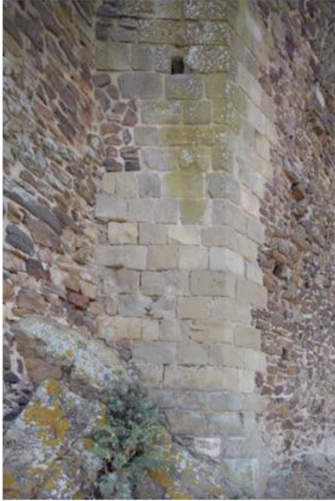
Fig. 14 - Detalle de la construcción de la muralla (foto de Unicity S.p.A.).
