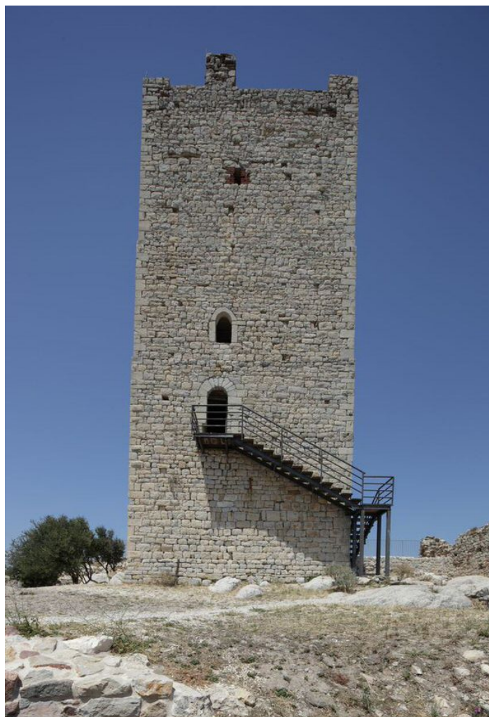
Fig. 1 - Entrada principal de la torre, lado este (foto de Unicity S.p.A.)
