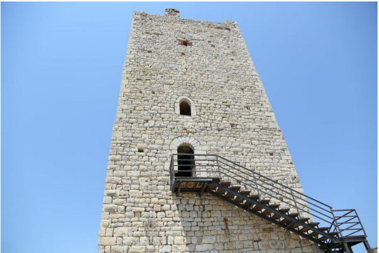
Fig. 5 - Fachada principal de la torre: se pueden observar las aberturas alineadas (foto de Unicity S.p.A.).
