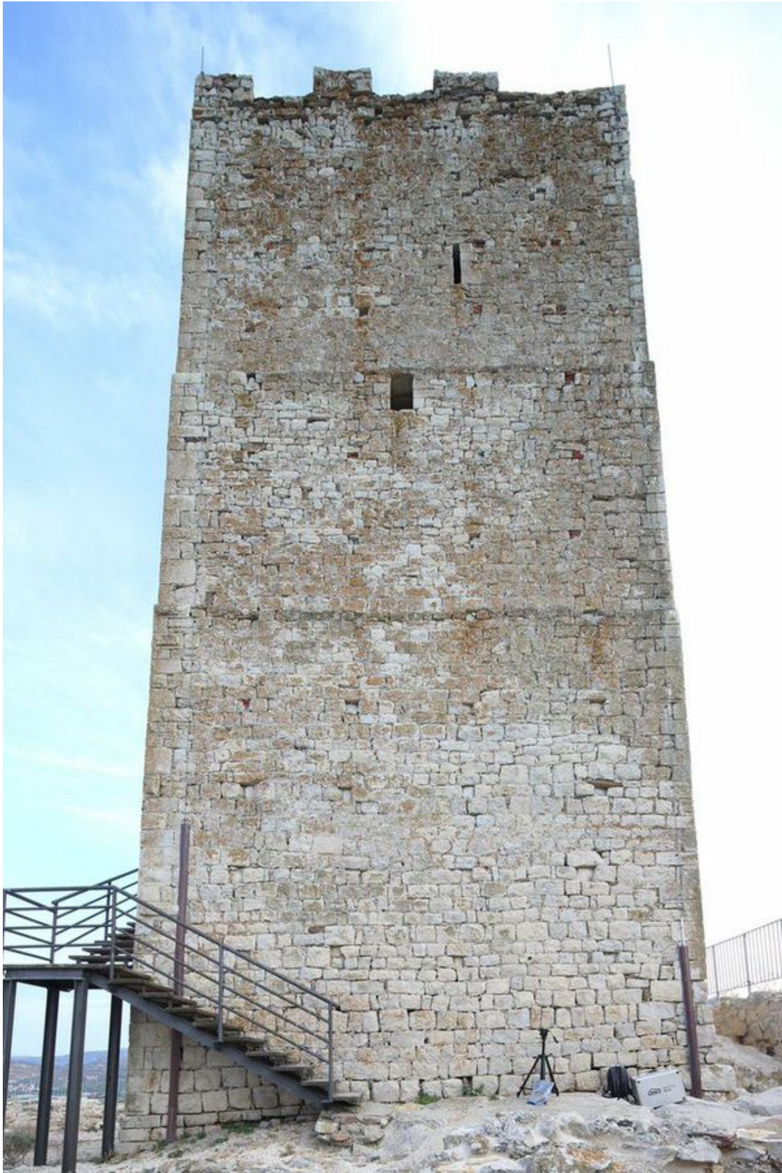
Fig. 4 - El lado norte de la torre: en los muros se notan los retallos que marcan los niveles del edificio (foto de Unicity S.p.A.).
