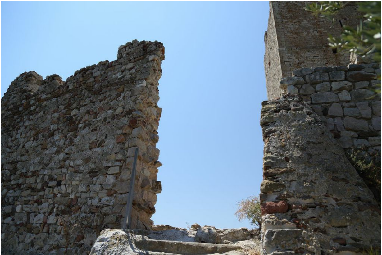
Fig. 2 - Muro vertical de la muralla (foto de Unicity S.p.A.)
