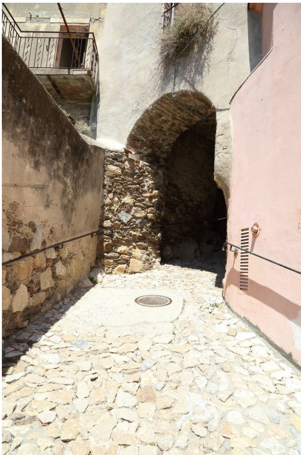
Fig. 2 - La segunda puerta del burgo de Posada, vista desde el exterior (foto d Unicity S.p.A.).
