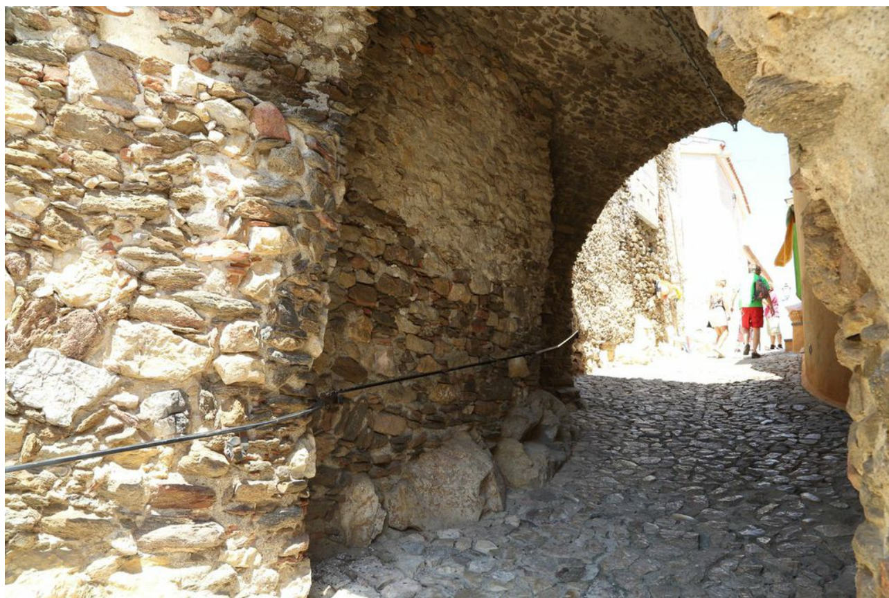
Fig. 3 - Paso a través de la segunda puerta (foto de Unicity S.p.A.).
