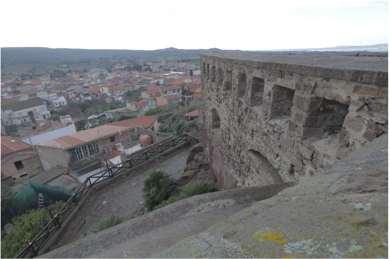
Fig. 6 - Aspilleras para los cañones a lo largo del perímetro de la fortaleza (foto de Unicity S.p.A.).
