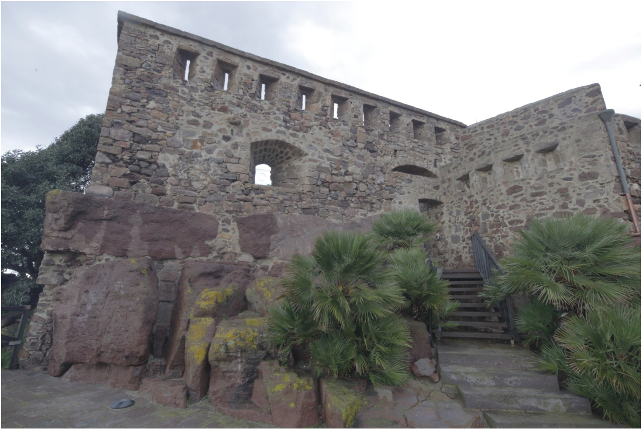
Fig. 2 - Fuerte de Saboya de Su Pisu (foto de Unicity S.p.A.)
