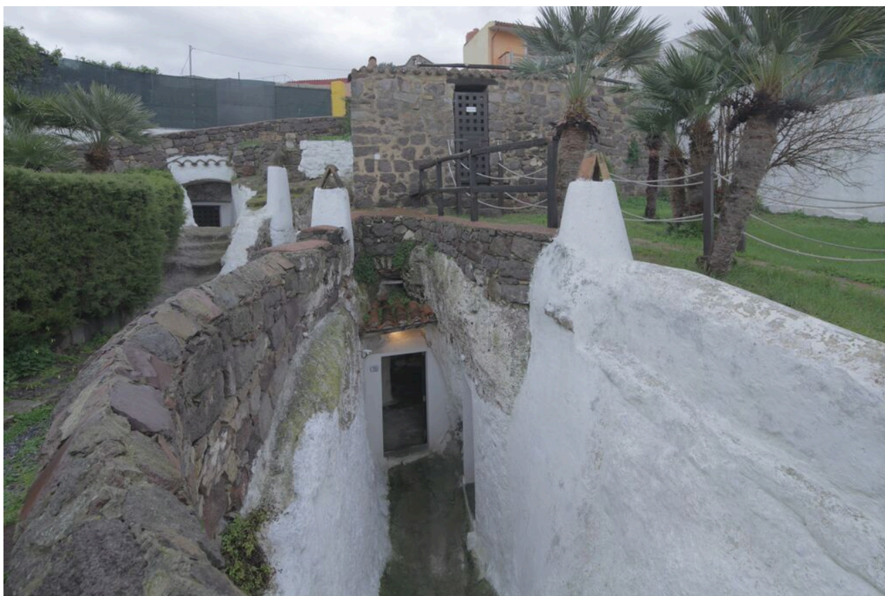
Fig. 11 - Entradas de las tumbas de dròmos convertidas en casas en la aldea hipogea (foto de Unicity).
