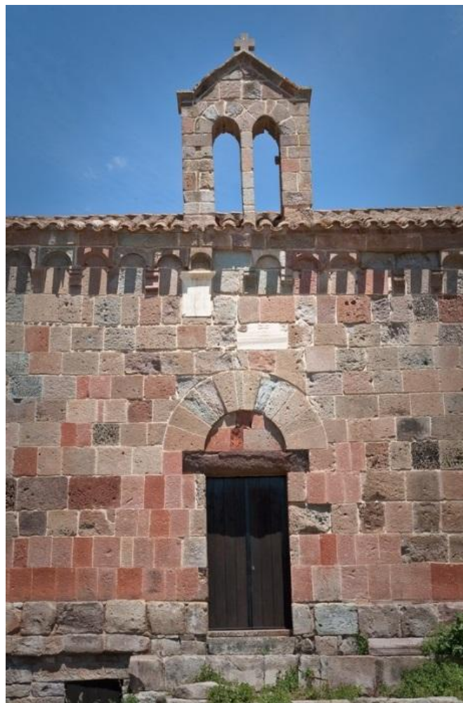
Fig. 1 - Fachada del lado sur de la iglesia de San Lussorio, construida en el siglo XII y reconstruida el siglo sucesivo debido a un derrumbe (foto P. Dessì, Archivo R.A.S.).
