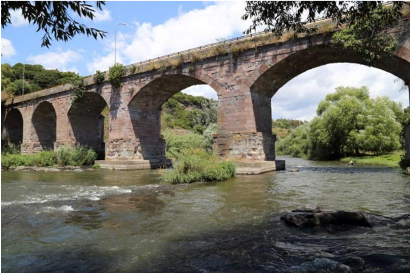
Fig. 4 - Puente sobre el Tirso en Fordongianus: los postes modernos se encuentran sobre la base del antiguo puente romano (foto de Unicity S.p.A.).
